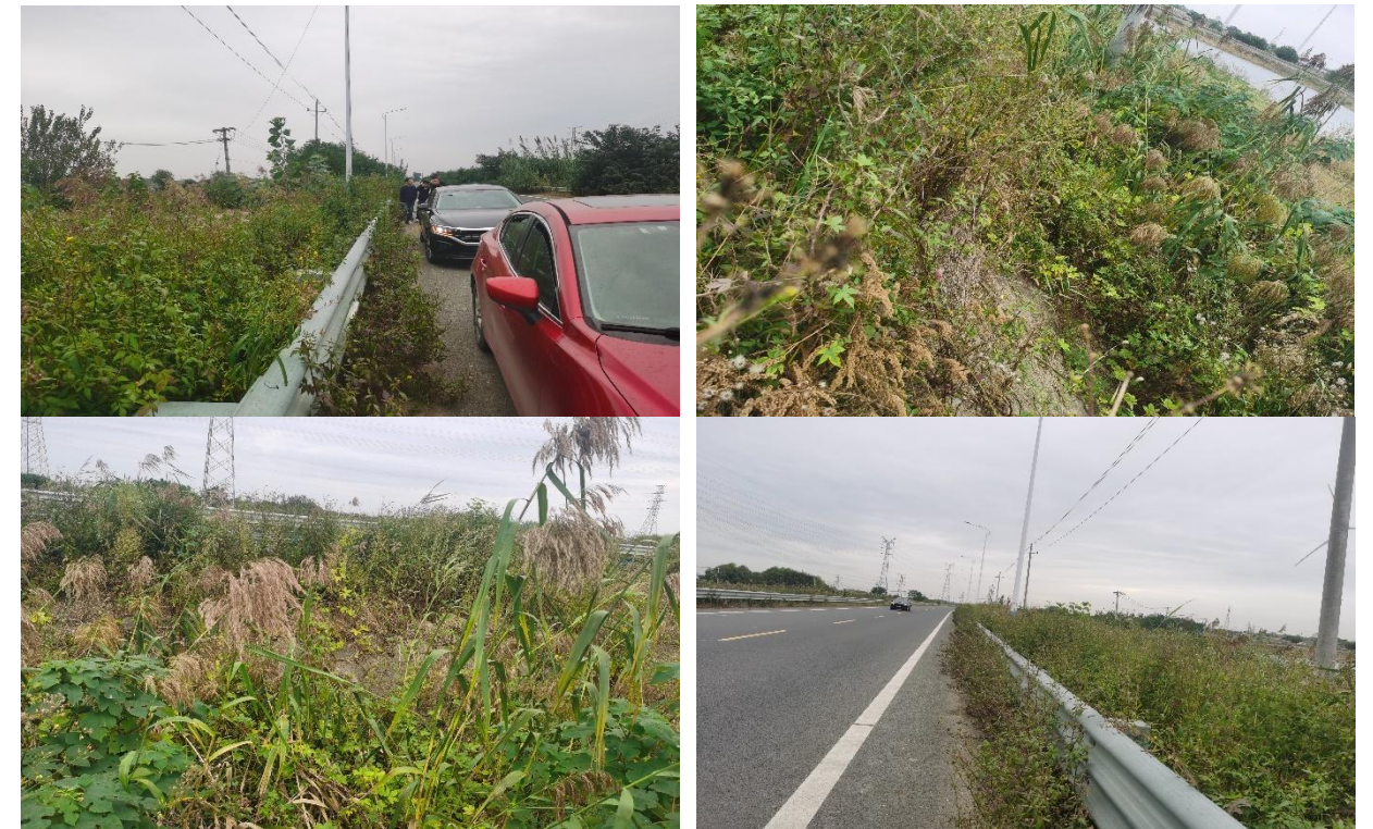
图 3-1 353 省道海陵区华港镇段边坡现状
